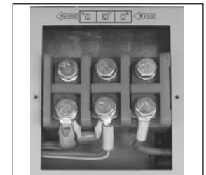
Рис. 6. Клеммник
